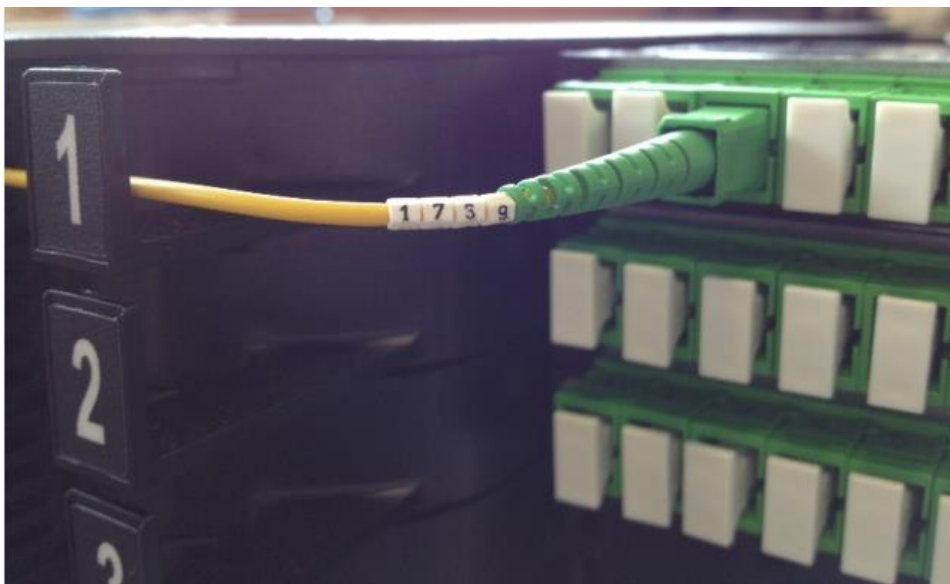
Figure 9. Repérage de cordons optiques à l'aide de cavaliers
