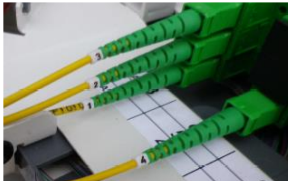
Figure 16. Exemple pose de cavalier sur cordon
